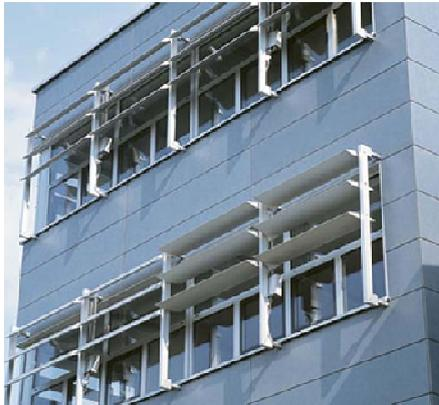
**Figure1** : Systèmes de protection solaire stationnaires extérieurs avec des lamelles horizontales.
