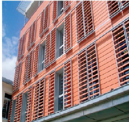
**Figure2** : Écrans solaires coulissants extérieurs à lamelles horizontales.
