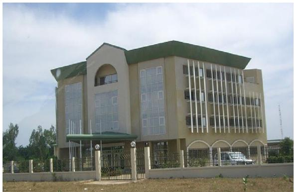
**Figure 4** : Systèmes de protection solaire stationnaires extérieurs avec des lamelles verticales (CBVIRA Tchad)
